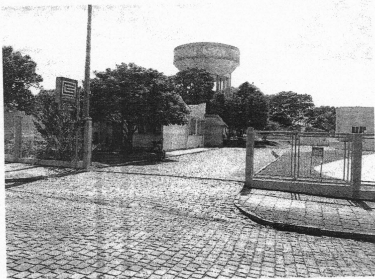
Foto 01– Unidade Administrativa/CORSAN – Nova Prata-RS
